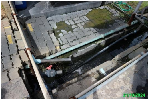
รูปที่ 3-7 รางระบายน้ำทิ้งจากหอหล่อเย็น
