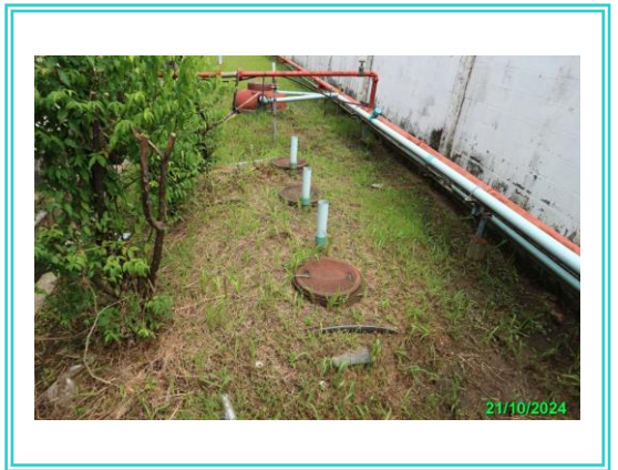
รูปที่ 3-4 ถังบำบัดน้ำเสียสำเร็จรูปบริเวณ Locker
