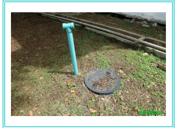
รูปที่ 3-2 ถังบำบัดน้ำเสียสำเร็จรูปในส่วนของสำนักงาน
