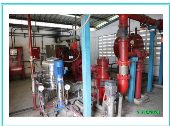
รูปที่ 3-31 ติดตั้งระบบบม้มน้ำดับเพลิง
