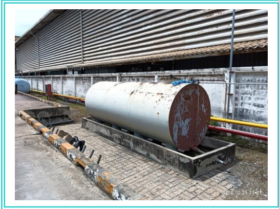
รูปที่ 3-1 ถังรวบรวมน้ำเสียจากการผลิต รอส่งกำจัด
